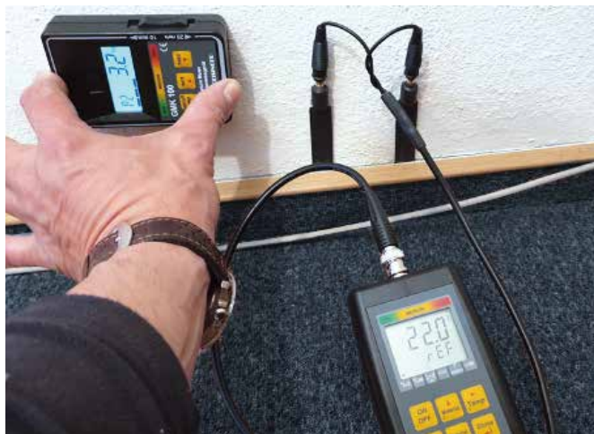
Messung in Estrichdämmung durch Randdämmstreifen: Feuchte unter dem Estrich GMH 3831 mit Flachelektroden
