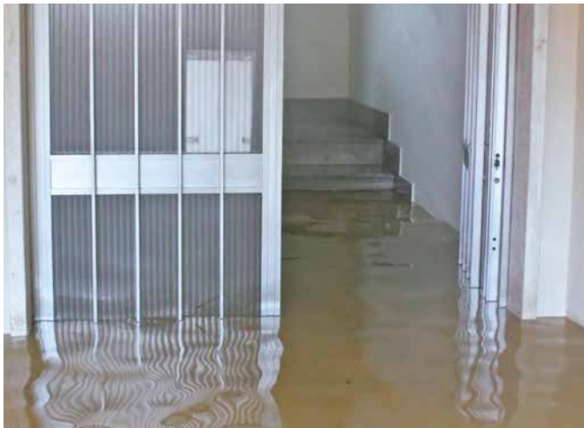
Durch starke Überflutung entstehen erhebliche Schäden an der gesamten Bausubstanz
